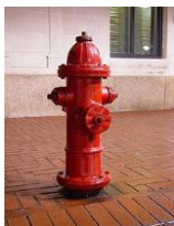
Idrante soprasuolo
